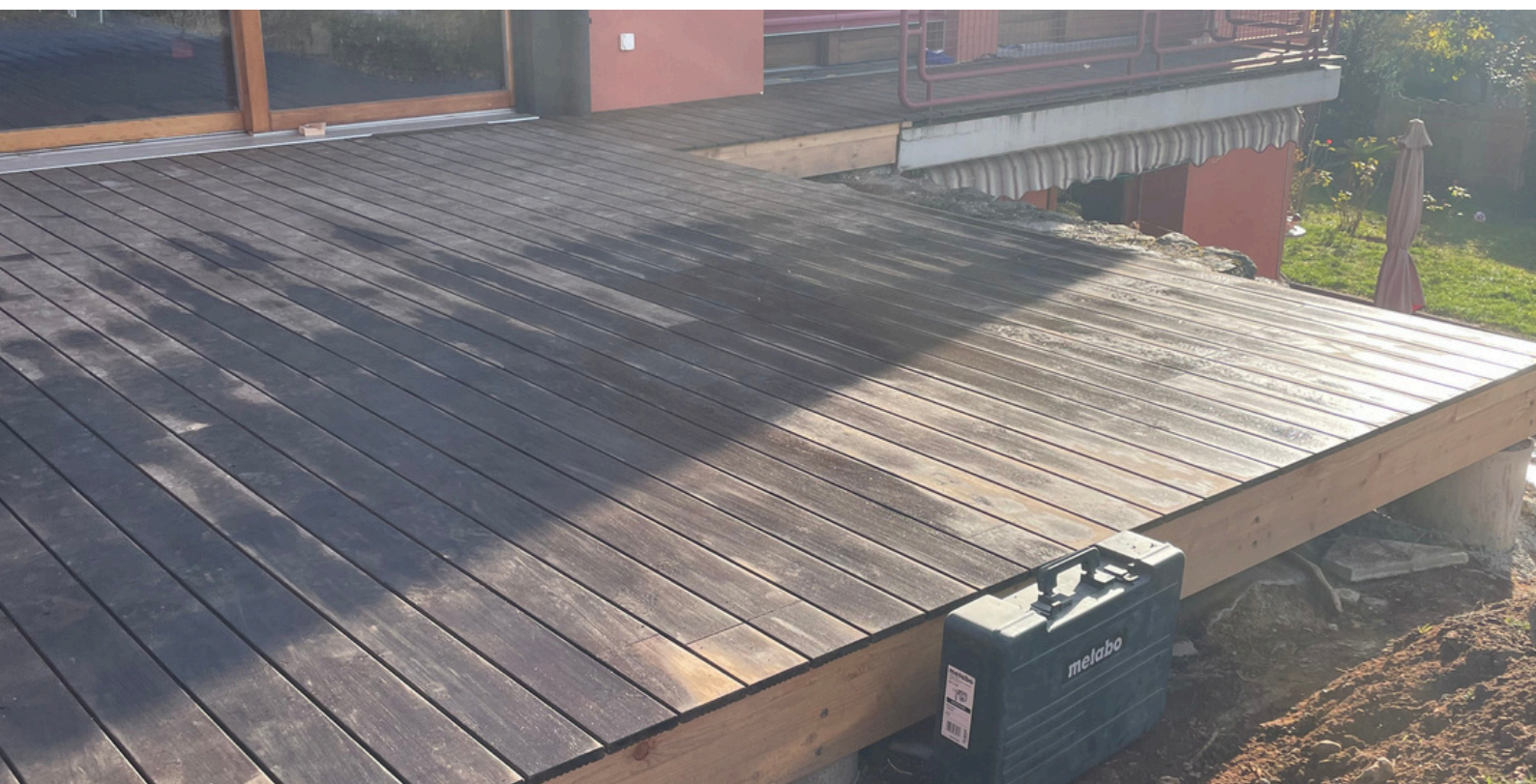
Terrasse en bois réalisée avec les participants de nos Ateliers
